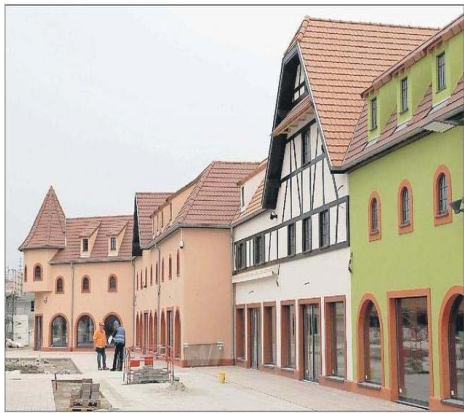
Im Stil eines elsässischen Dorfes: Die Bauarbeiten am neuen Outlet bei Roppenheim sind weit fortgeschritten.
